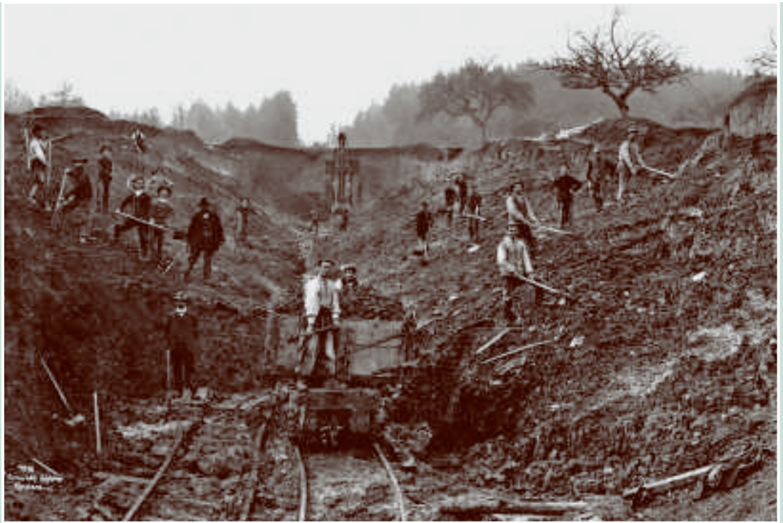
Erdarbeiten oberhalb der Station Lengwil nach einer Hangrutschung. Ein Teil des bereits fertiggestellten Einschnittes wurde nach einem Unwetter zugeschüttet. Zuerst musste der Dampfbagger im Hintergrund befreit werden, 1910 • (wolf)
