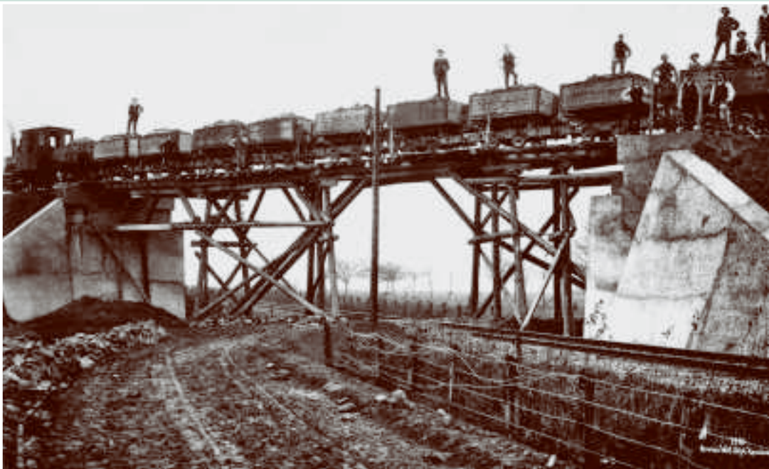
Erdarbeiten oberhalb der Station Lengwil nach einer Hangrutschung. Ein Teil des bereits fertiggestellten Einschnittes wurde nach einem Unwetter zugeschüttet. Zuerst musste der Dampfbagger im Hintergrund befreit werden, 1910 • (wolf)
